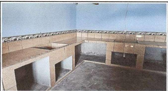
Foto 10: implementación de gabinete con lavatrastos de concreto, azulejado totalmente pintada.
