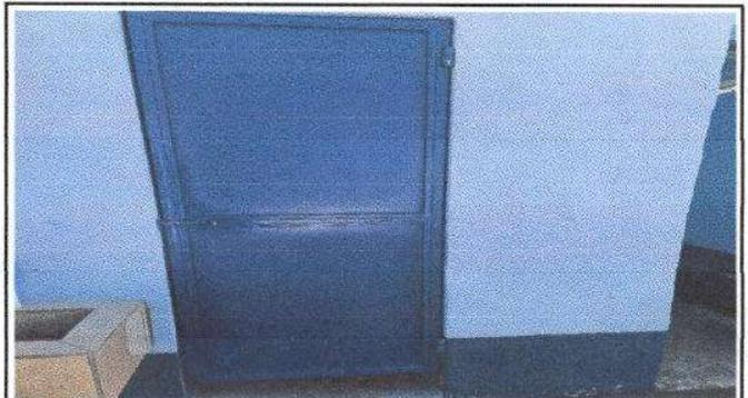
Foto 2: Sustitución de puertas de madera por puertas de metal en servicios sanitarios.
